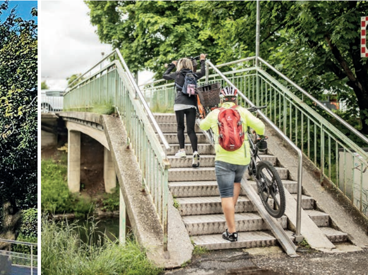
Der neue Heinzelsteg wird 22 Meter lang und mit einem schlanken Stahltragwerk ausgestattet sein. Geländer aus Edelstahl sorgen für ein transparentes Erscheinungsbild (links). Die derzeit noch bestehende, steile Treppe stellt vor allem Radfahrer, Menschen mit Kinderwägen und gehbehinderte Personen vor Probleme (rechts). Visualisierung: DI Heimo Kramer, Foto: Zangerle
