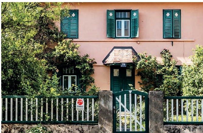
Straßenfest mit Projektvorstellung „Ingeborg-Bachmann-Haus“ (Henselstraße) am 17. Juni ab 18 Uhr. Foto: Puch
