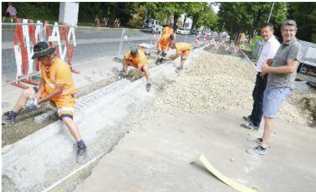
Der Radweg in der Feldkirchner Straße entlang der Turracher Bundesstraße wurde nun beleuchtet (Foto rechts). In der St. Ruprechter Straße wird an der Ostseite beim Park der Radweg neu angelegt, Stadtrat Christian Scheider und Gottfried Mirnig überzeugten sich vom Baufortschritt. Fotos: Wajand
