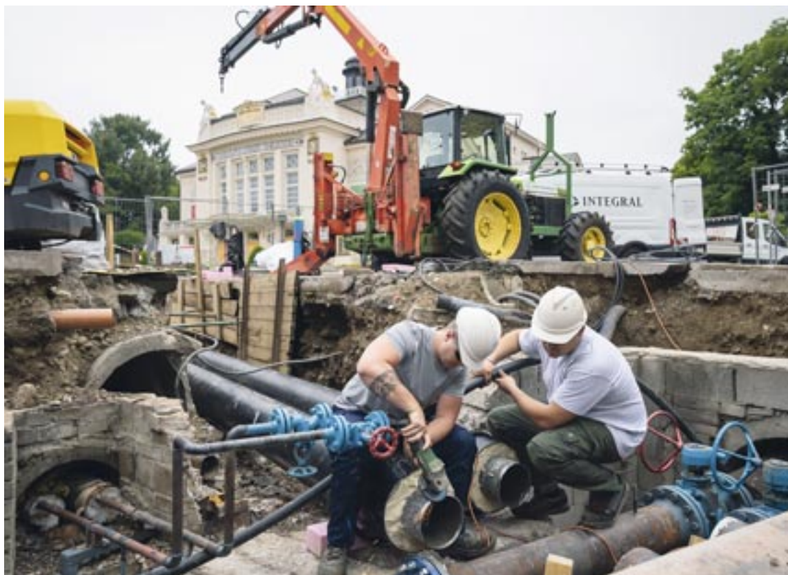
Stetig werden die Leitungen der STW, wie hier vorm Stadttheater, saniert und auf den neuesten Stand gebracht.
