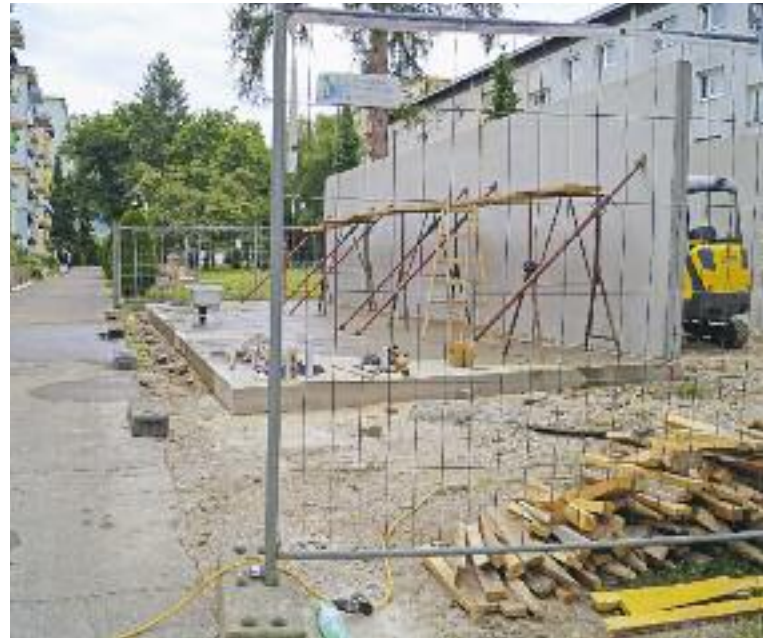
Nachdem es in Fischl in der Vergangenheit immer wieder zu Müllinselbränden kam, werden nun zwei sichere versperrbare Müllinseln errichtet. Foto: KK
