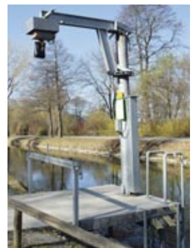
Die Bootshebeanlage Lendkanal geht im April in Betrieb. Foto: SK
