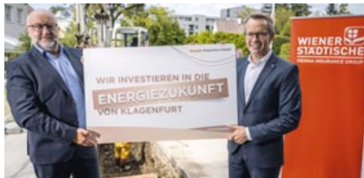
STW-Vorstand Erwin Smole und Ferdinand Bucher (Landesdirektor Wiener Städtische Kärnten/Osttirol) besichtigen die Fernwärmebaustelle. Foto: Bauer
