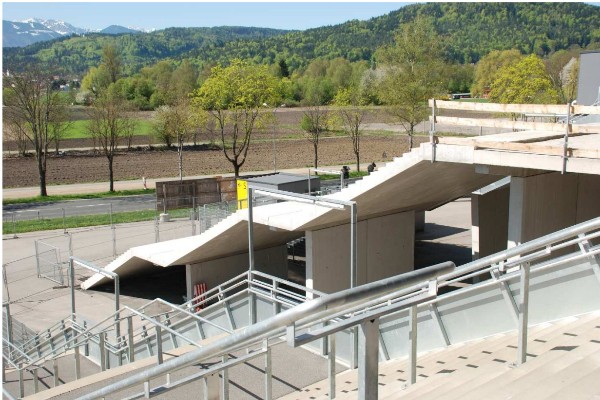
Abbildung 9: Ersatz der Stahlstiegen durch eine Stahlbetonkonstruktion
