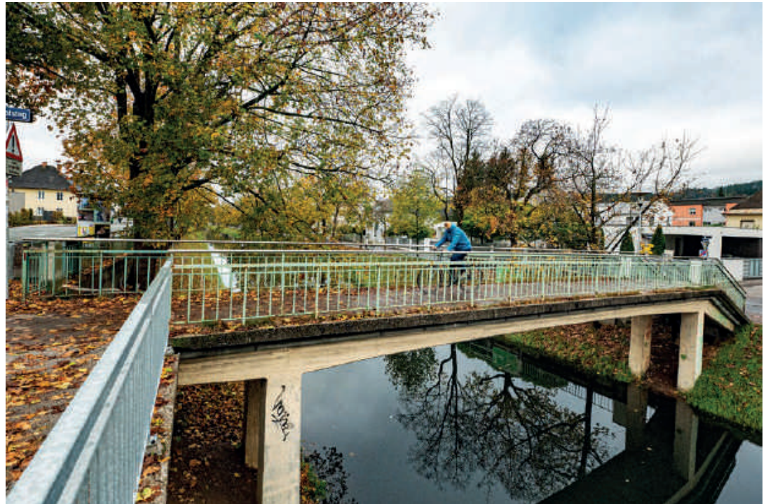
Der Heinzlsteig soll künftig einfacher zu überqueren sein. Fotos: Hude
