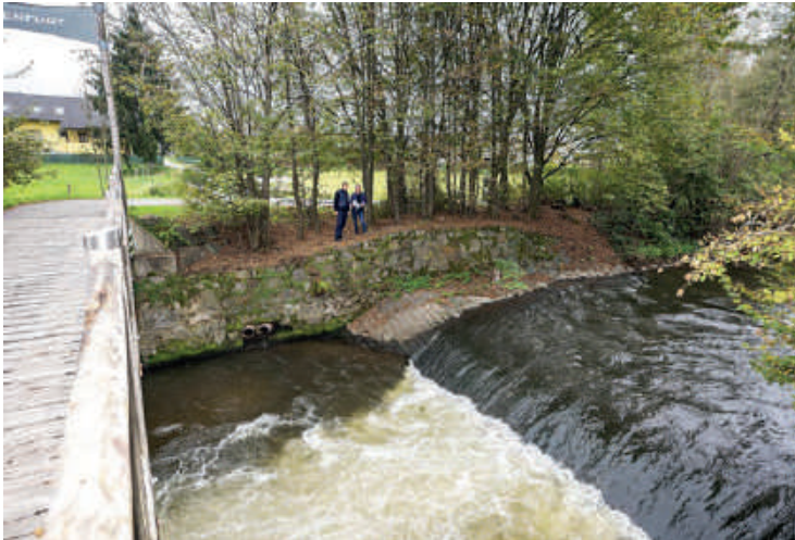
Diese Sohlstufe in der Glan wird mit einem Fischaufstieg entschärft. Fische kommen so wieder zu Laichplätzen, eine Insel entsteht. Foto: Hude
