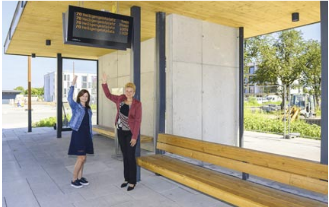
Die beiden zuständigen Referentinnen der Stadt Klagenfurt, Stadtplanungsreferentin Stadträtin Mag. Corinna Smrecnik und Straßenbaureferentin Stadträtin Sandra Wassermann waren kürzlich in Harbach, um sich die Baufortschritte zum Mobilitätsknoten anzusehen. Foto: Hude
