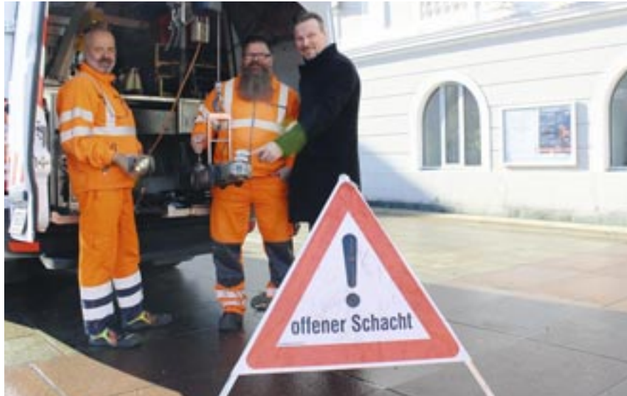
Entsorgungsreferent Vizebürgermeister Wolfgang Germ testet mit den Mitarbeitern der Abt. Entsorgung den Kamerawagen für die Überprüfung des Klagenfurter Kanalnetzes.
